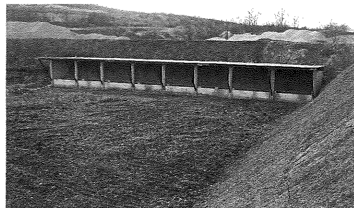
100 m Stand, Blick vom Wall Richtung Westen
